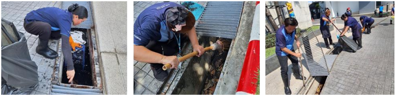
ภาพที่ 3-1 การดูแล บำรุงทำความสะอาดรางระบายน้ำ
