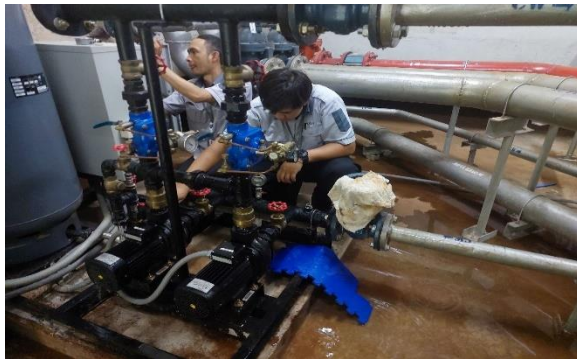
ซ่อมบำรุงระบบส่งน้ำใช้
